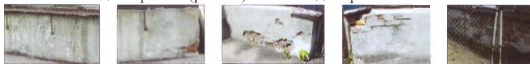
фрагменты фундамента лит.Ж1
