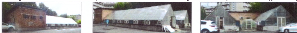
Рис. 30, общий вид Здания теплицы
